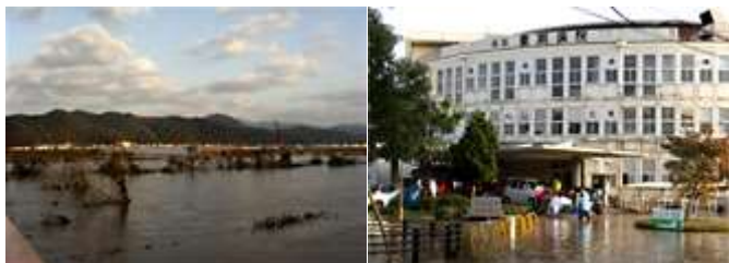
← 浸水した公立豊岡病院
